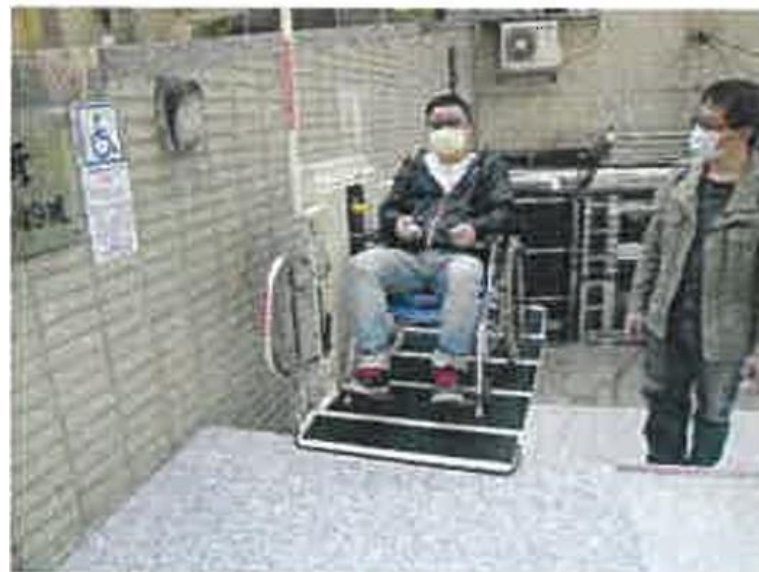
台北市翠光新第管委會樓梯式輪椅平台現場安裝配置示意圖
