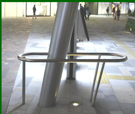
日本某車站前的傾斜柱子下方設有欄杆，可避免路人不慎撞到。
