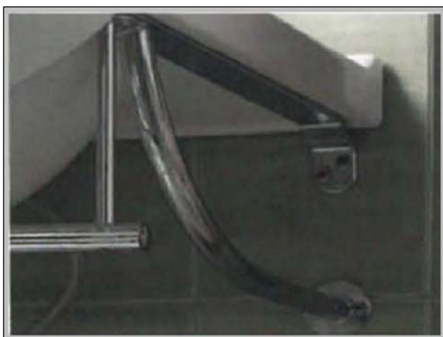
圖5-66壁掛式洗面盆加設支撐
